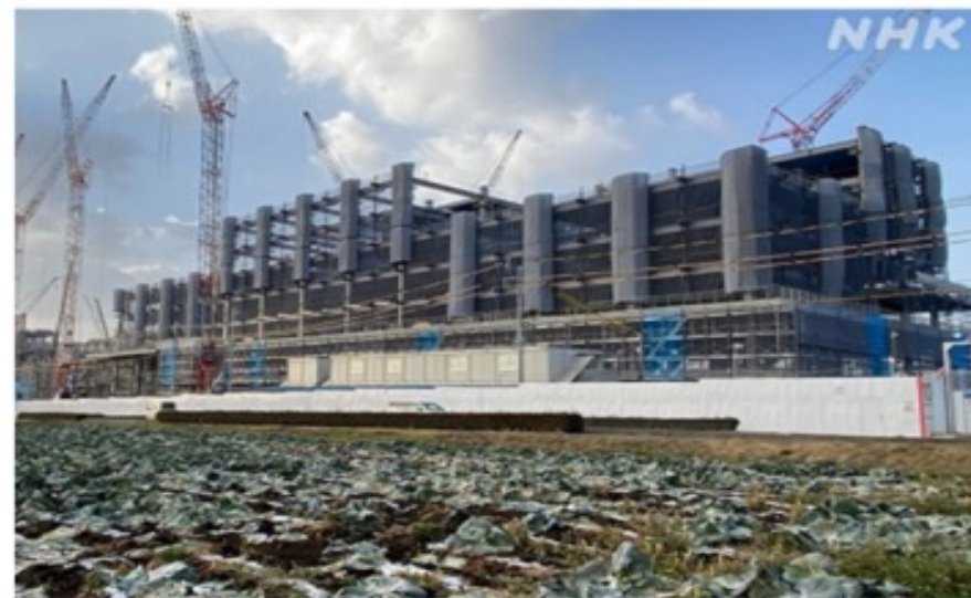
建設中のTSMCの工場
